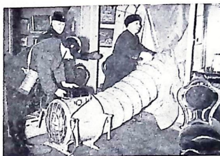
Ventilationsluft intages med hjälp av en elektrisk ventilator.
